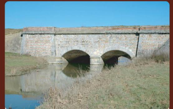
Prospetto delle bocche d'ingresso delle due canne della Botte
