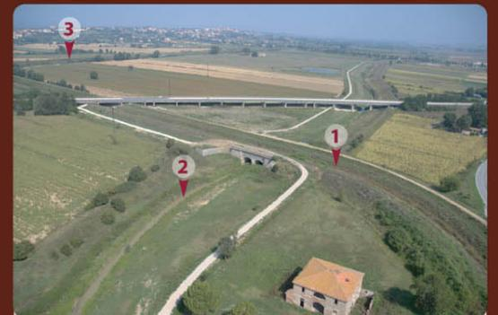
Mediante la botte allo Strozzo l'Allacciante delle Chianacce (1) passa sopra al Canale Maestro della Chiana (2) per immettersi nell'allacciante di sinistra (3)
