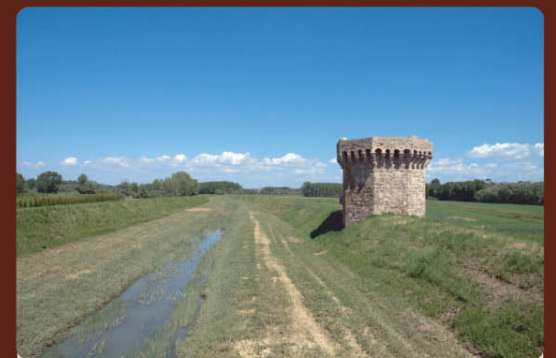
La Torre di Beccati Questo è inglobata per circa due terzi nell'argine destro del canale della Tresa
